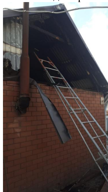
Чердачное помещение бани ст. Нововладимировская
