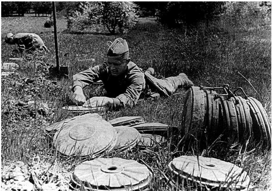
Советский сапер старшина Григорий Крупин из 185-го батальона инженерных заграждений 13-й отдельной инженерной бригады специального назначения обезвреживает снятые с минного поля германские противотанковые мины "Tellermine 35".
